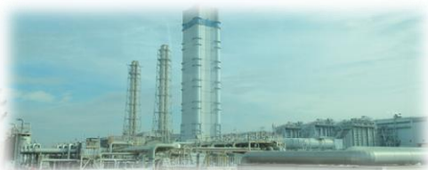
<富津火力発電所>
