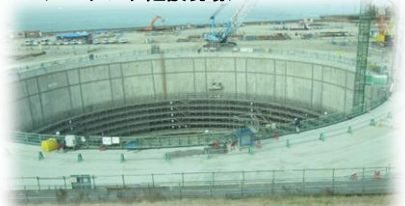
<LNGタンク建設現場>
